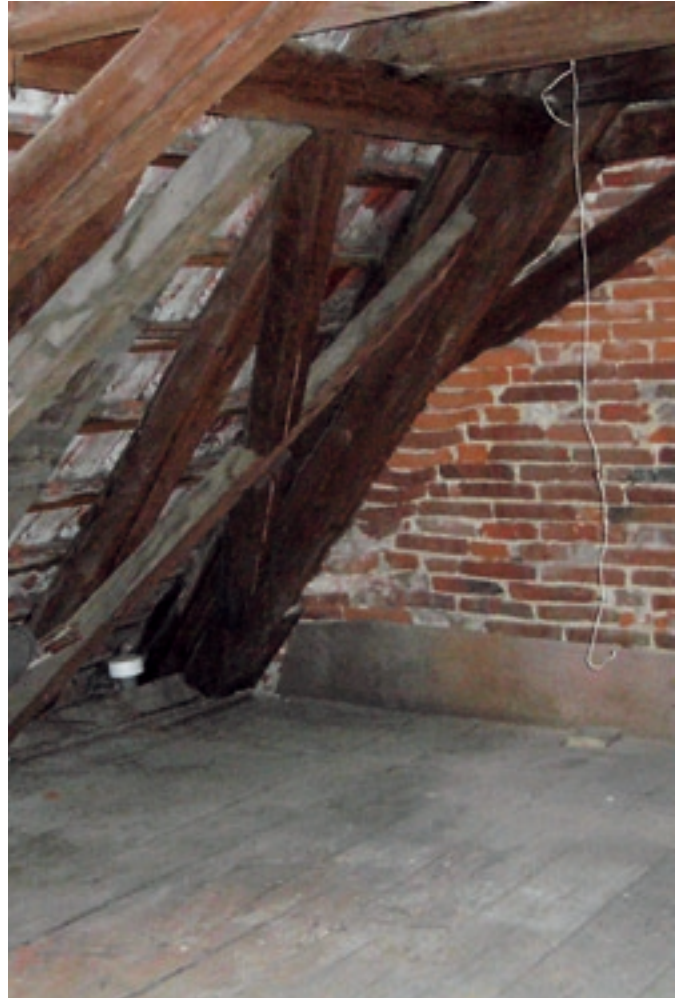
DACHSTUHL IM UNSANIERTEN ZUSTAND
